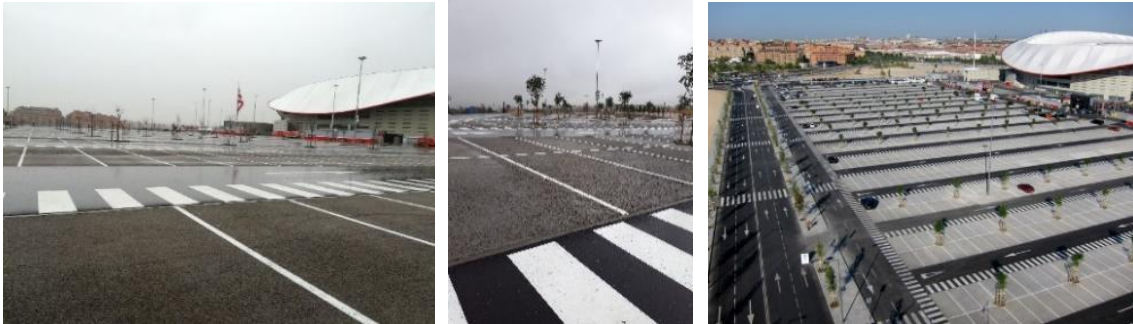
Ilustración 8: Pavimento permeable en el Estadio del Atlético del Madrid. Fuente: Ayto. de Madrid.
